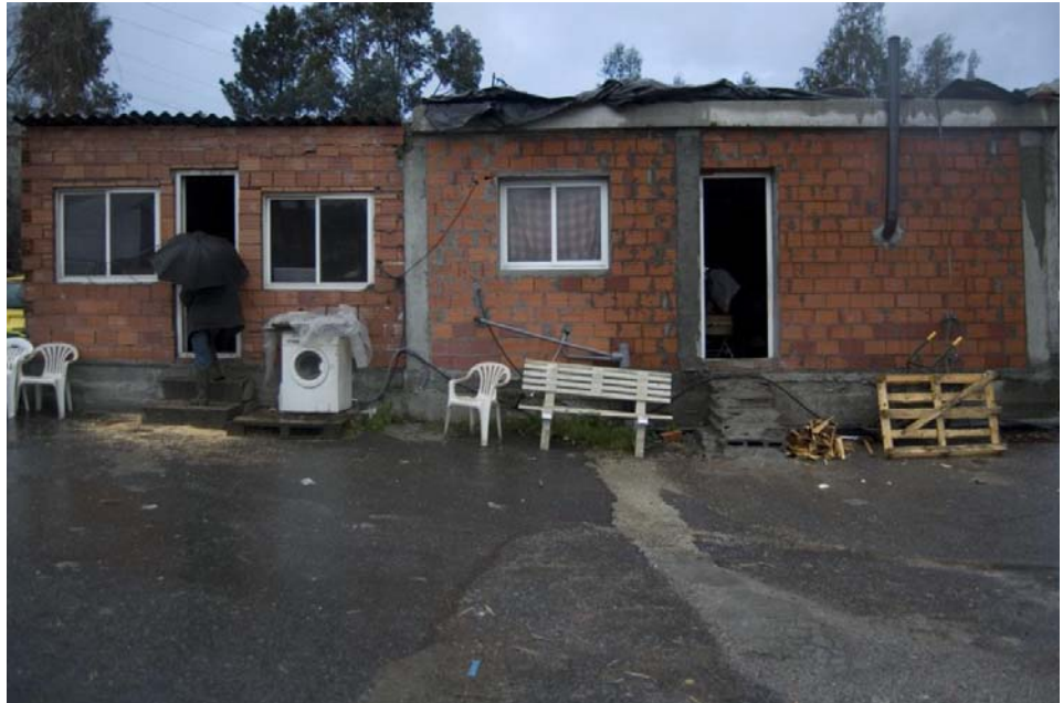
Foto 5 – Vista das fachadas de dúas das vivendas do barrio. Febreiro 2009. Obsérvase cómo a vivenda da dereita (nº8) cúbrese superiormente por unha lona de plástico, que cubre o forxado de formigón da futura planta primeira. Os traballos por parte de persoal contratado polo Concello na vivenda paralizáronse a finais do ano 2007. Véxanse foto 6.
