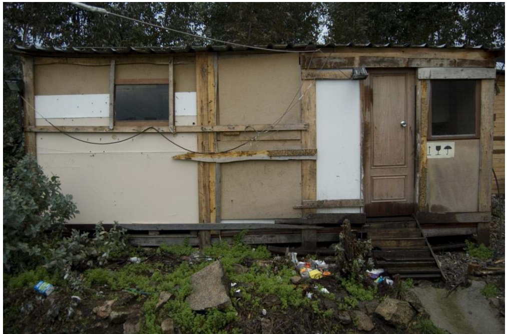
Foto 4 – Construción provisional construída polas familias como aloxamento temporal previsto durante o transcurso das obras no barrio, cuxa duración estimada inicialmente era duns 6 meses. Despois da demolición das 3 vivendas por parte de persoal contratado polo Concello, transcorreron mais de dous anos durante os que as familias continuaron sen vivenda.
